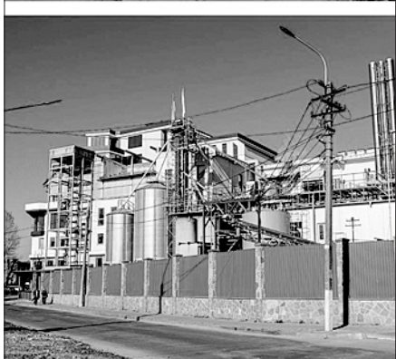
Фото пивзаводу та виробничі склади до та після реконструкції
